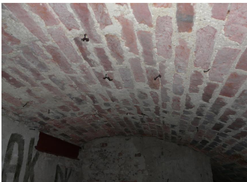
Na sklepieniu i ścianach widoczne resztki tynku w kolorze beżowym, o grubym ziarnie.
