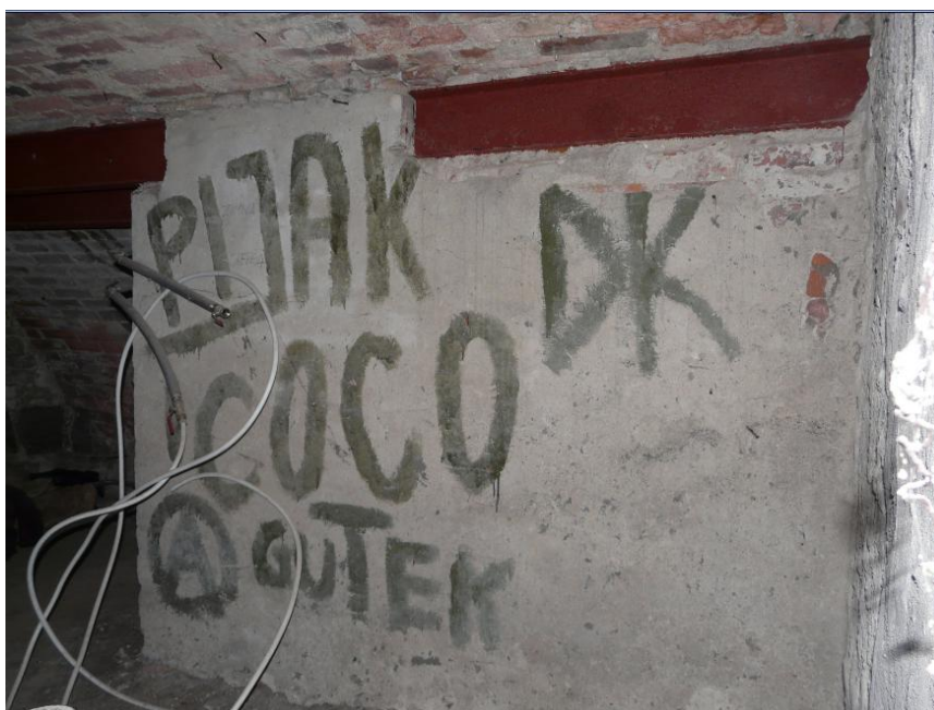
Fragment ściany z napisami i stalowy dwuteownik.
