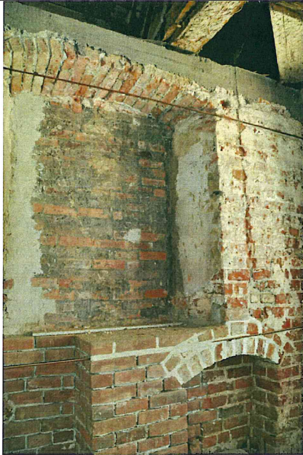
Fot. 9 Wnętrze dworu Kleista. Ściana południowa budynku, jej zachodnia część. Nowożytny otwór okienny przebity w starszym murze, a następnie zamurowany.
