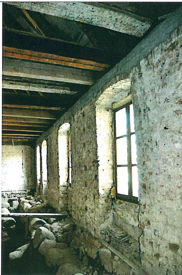
Fot. 2 Wnętrze dworu Kleista. Pomieszczenie wzdłuż wschodniej ściany budynku. Korona muru wzmocniona wieńcem żelbetowym wykonanym w latach 90-tych XX w.
