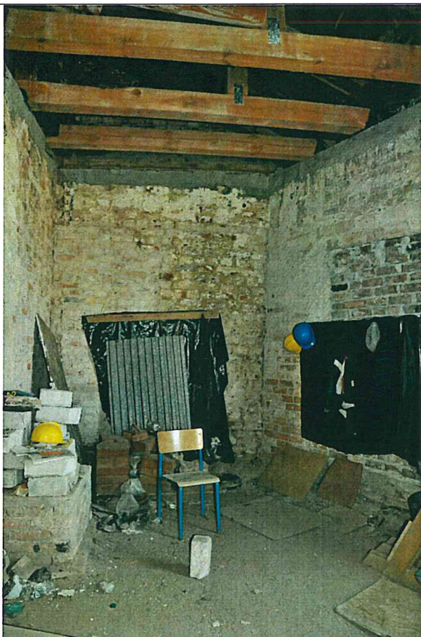
Fot. 5 Wnętrze dworu Kleista. Pomieszczenie w północnej, dobudowanej części budynku. W ścianie na wprost zamurowane okno.
