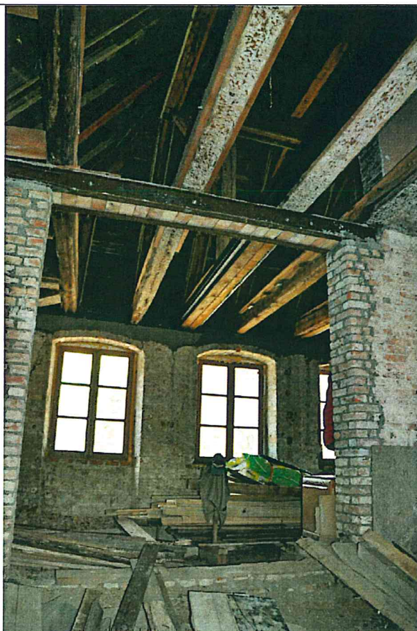
Fot. 11 Nowo wykonane przejście pomiędzy sienią, a pomieszczeniem w głębi dworu. Wstawiono stalowe nadproże, wymurowano na nowo ościeża otworu. Powyżej widoczne wykonane wzmocnienia drewnianej konstrukcji dachu.
