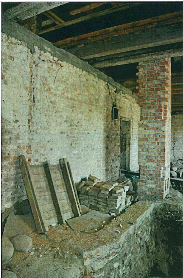
Fot. 3 Wnętrze dworu Kleista. XX – wieczna ściana działowa dzieląca budynek w poprzek.
