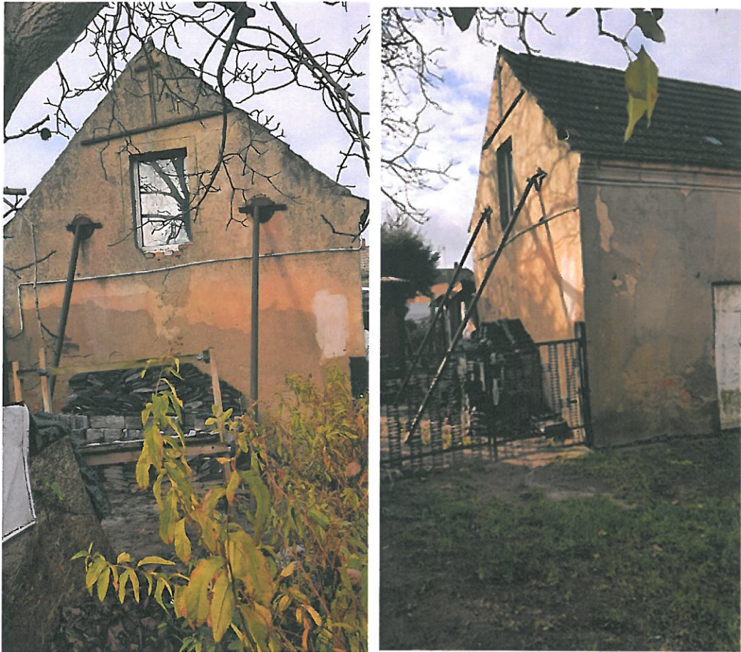
zdj. nr 2 – elewacja szczytowa, str. południowa.
