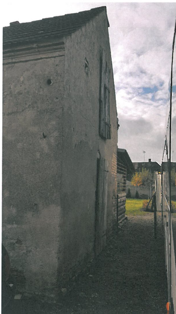
zdj. nr 4 – elewacja szczytowa- str. północna.
